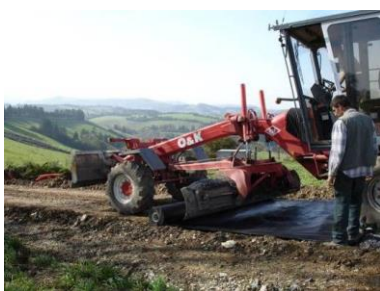
Pose du géotextile
