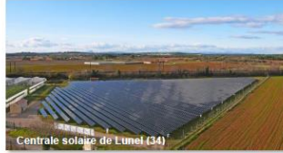
Centrale solaire de Lunel (34)
