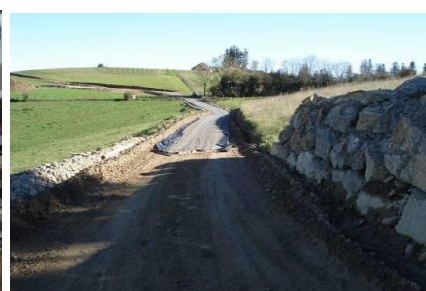
Mise en place du gravier
